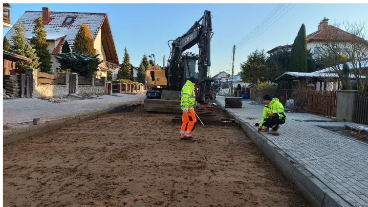
Foto. 15. Budowa ul. Kopernika.
