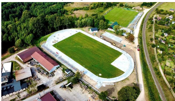
Foto. 93. Budowa stadionu lekkoatletycznego.
