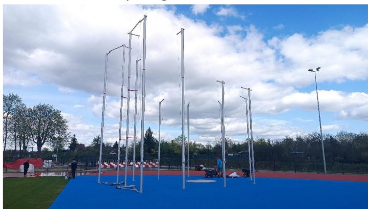
Foto. 39. Budowa stadionu lekkoatletycznego.
