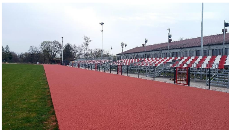
Foto. 38. Budowa stadionu lekkoatletycznego.
