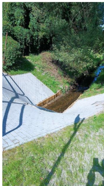
Foto. 29. Przepust ul. Skarszewska.
