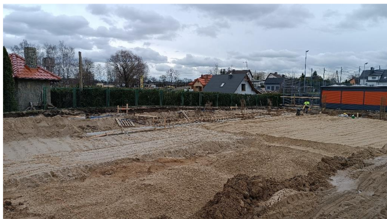
Foto. 42. Budowa nowej szkolnej hali sportowej.
