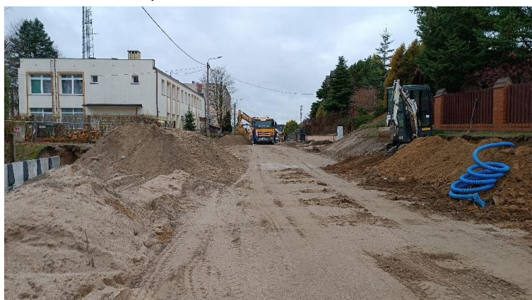
Foto. 22. Przebudowa ul. Brzechwy.
