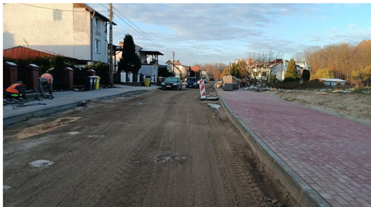
Foto. 13. Budowa ul. Kopernika.
