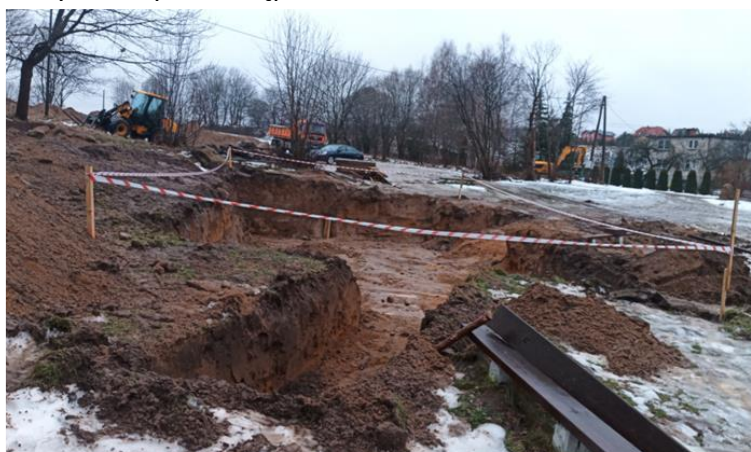
Foto. 46. Budowa budynku zaplecza kąpieliska.
