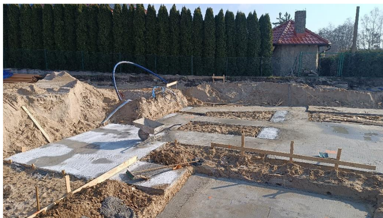
Foto. 45. Budowa nowej szkolnej hali sportowej.
