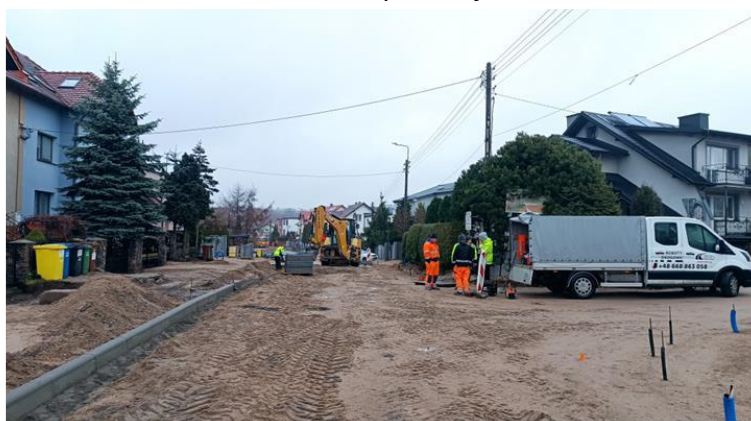
Foto. 19. Przebudowa sieci wod-kan w ul. Konopnickiej.
