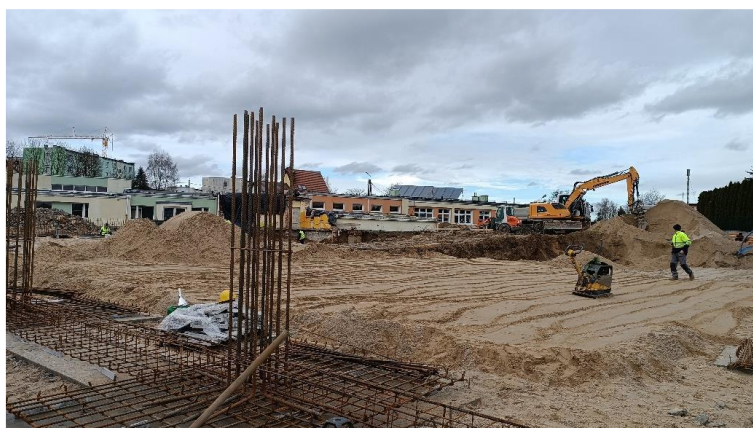
Foto. 43. Budowa nowej szkolnej hali sportowej.
