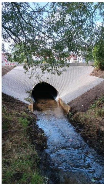
Foto. 28. Przepust ul. Skarszewska.
