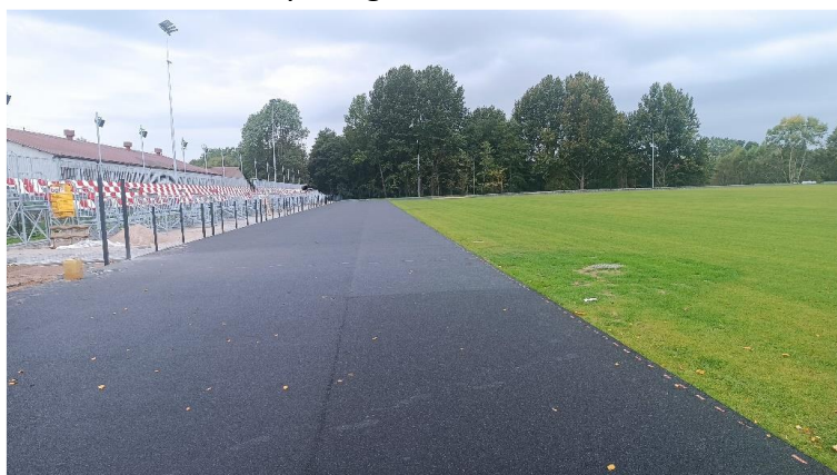
Foto. 36. Budowa stadionu lekkoatletycznego.
