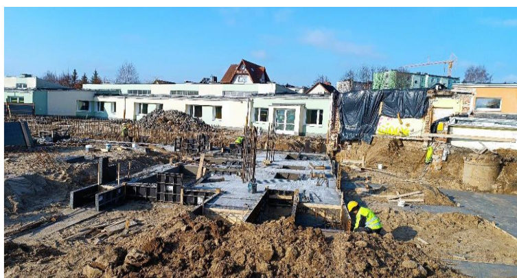
Foto. 44. Budowa nowej szkolnej hali sportowej.
