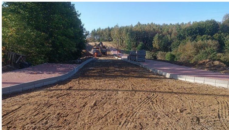
Foto. 14. Budowa ul. Kopernika.
