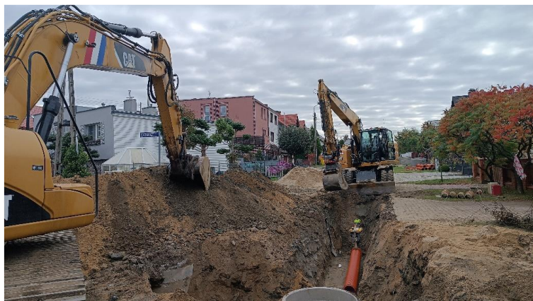
Foto. 21. Przebudowa kanalizacji deszczowej w ul. Konopnickiej.
