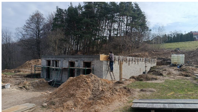
Foto. 47. Budowa budynku zaplecza kąpieliska.
