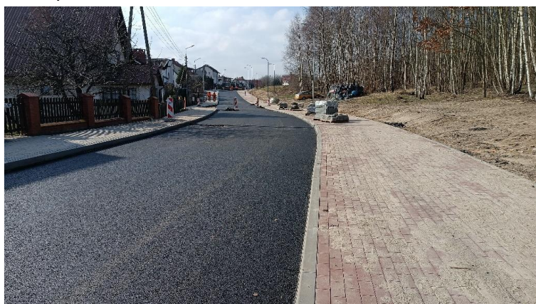
Foto. 17. Budowa ul. Kopernika.
