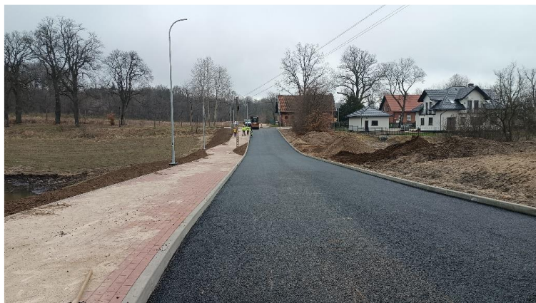
Foto. 18. Budowa ul. Kopernika.
