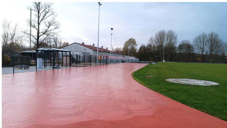
Foto. 37. Budowa stadionu lekkoatletycznego.
