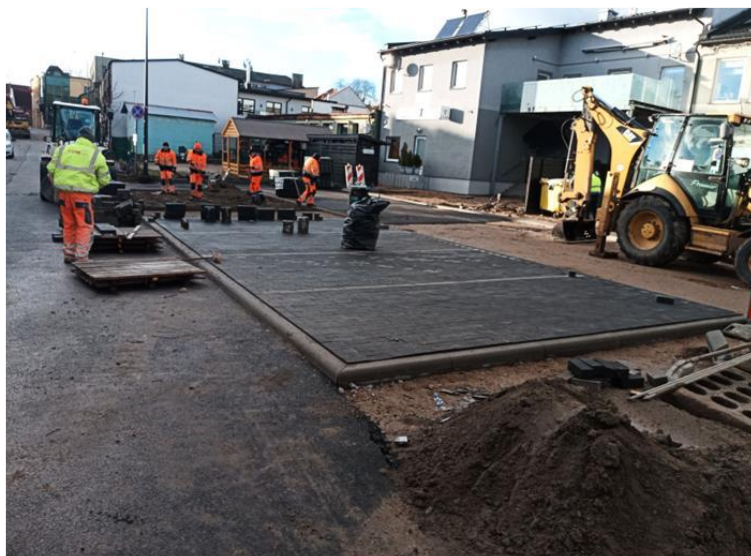
Foto. 24. Budowa miejsc parkingowych przy ul. Kowalskiej.
