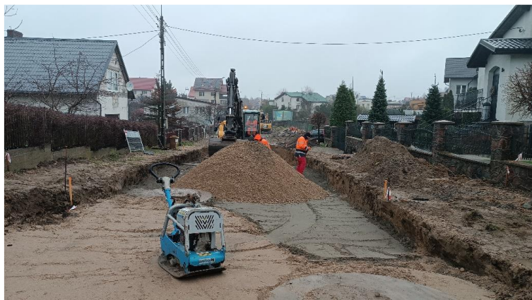
Foto. 20. Przebudowa sieci wod-kan w ul. Konopnickiej.
