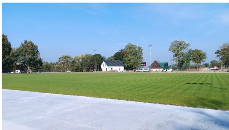
Foto. 35. Budowa stadionu lekkoatletycznego.
