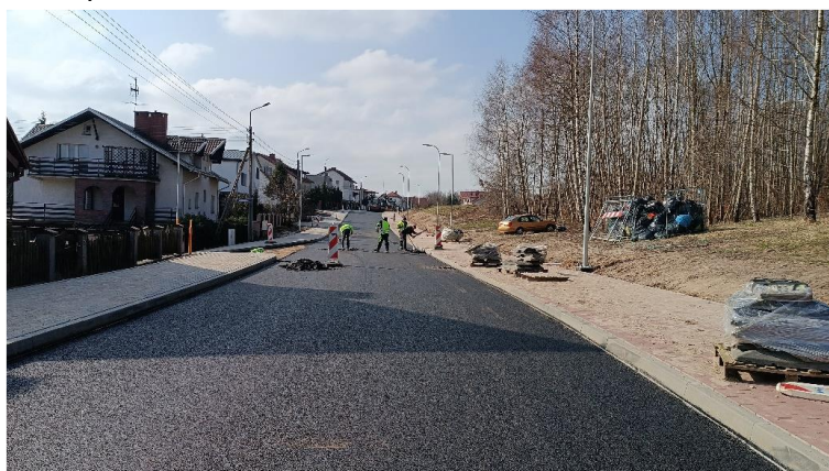
Foto. 16. Budowa ul. Kopernika.
