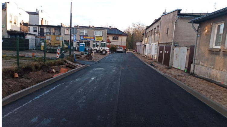
Foto. 26. Przebudowa ul. Kowalskiej.
