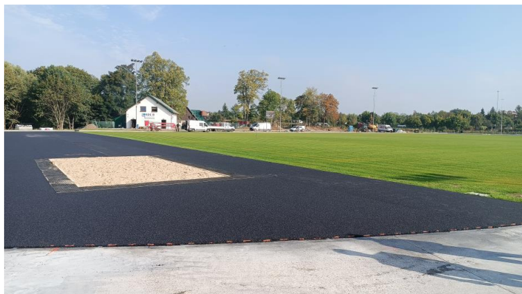
Foto. 34. Budowa stadionu lekkoatletycznego.
