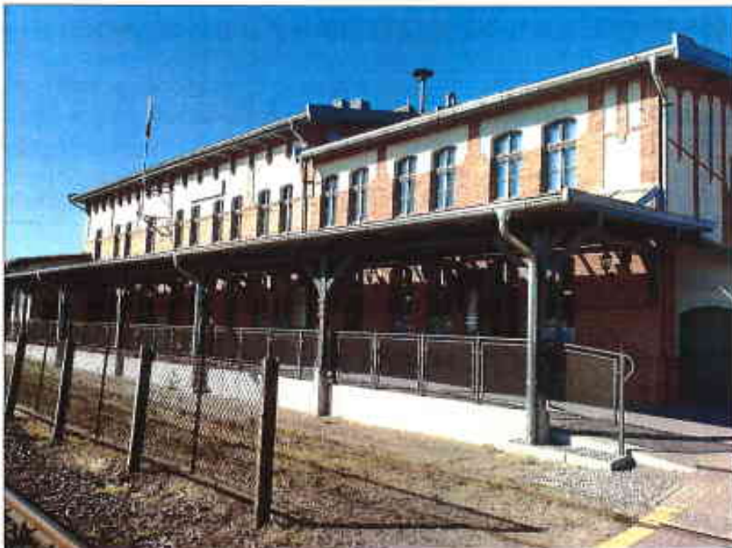
Zdjęcie nr 2, Dworzec kolejowy w Kościerzynie po modernizacji.
