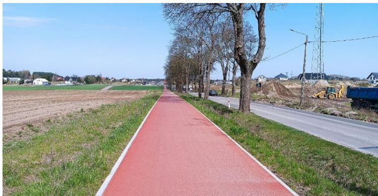
Foto. 3. Droga rowerowa w kierunku Skorzewa
