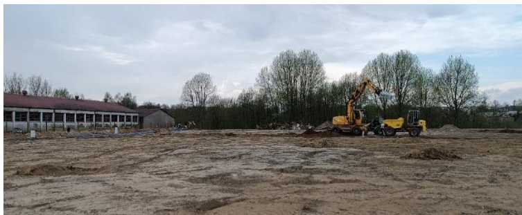
Foto. 18. Budowa stadionu lekkoatletycznego
