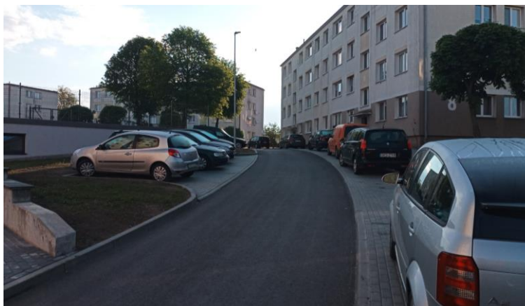
Foto. 15. Rewitalizacja drogi na ul. Kartuskiej wewnątrzsiedlowej
