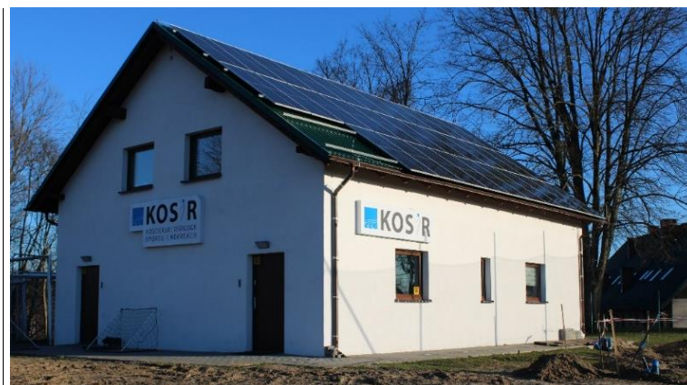
Foto. 41. Nowy budynek socjalno-magazynowy przy płycie treningowej
