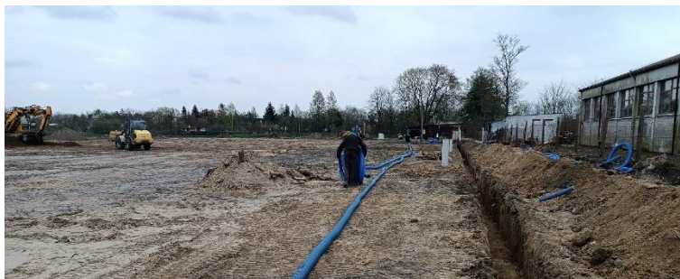
Foto. 19. Budowa stadionu lekkoatletycznego
