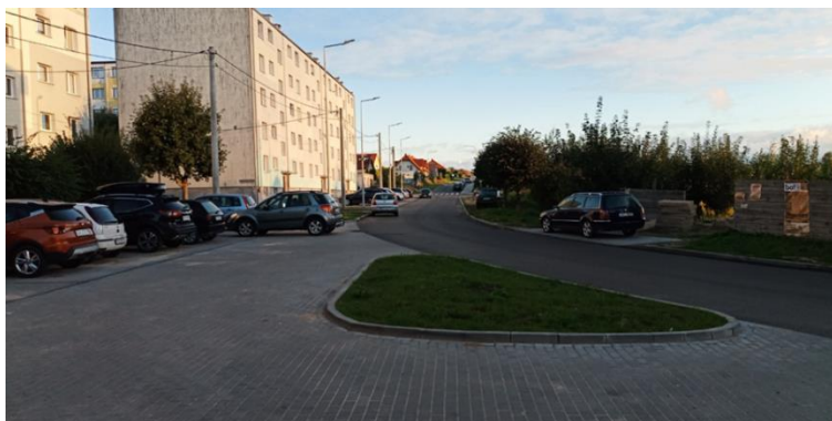
Foto. 13. Rewitalizacja drogi na osiedlu 1000-lecia
