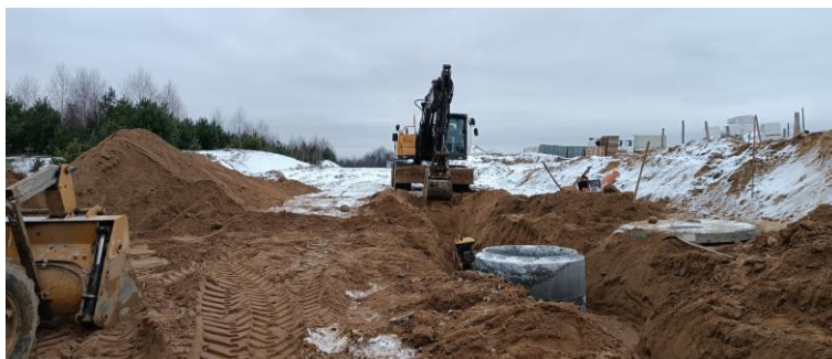
Foto. 20. Budowa ul. Paderewskiego.
