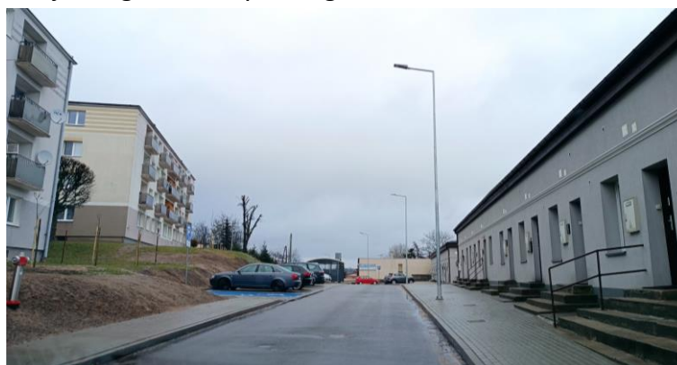
Foto. 16. Rewitalizacja drogi na ul. Wybickiego
