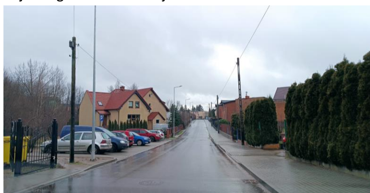
Foto. 17. Rewitalizacja drogi na ul. Jeziornej
