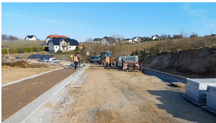
Foto. 22. Budowa ul. Małej Kolejowej.
