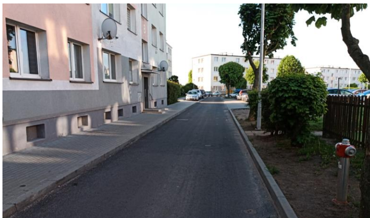
Foto. 14. Rewitalizacja drogi na ul. Kartuskiej wewnątrzsiedlowej
