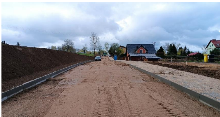
Foto. 21. Budowa ul. Małej Kolejowej.
