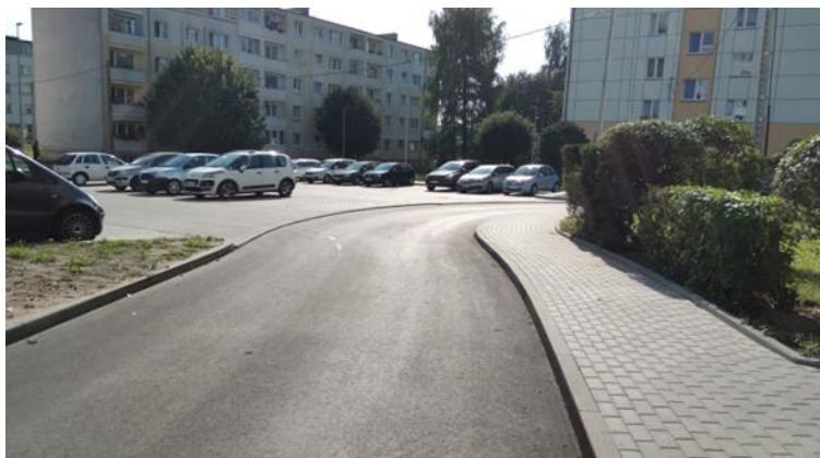
Foto. 12. Rewitalizacja drogi na osiedlu 1000-lecia
